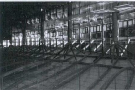
新宮健康増進センター(和歌山県新宮市)/設計：古橋建築事務 所
