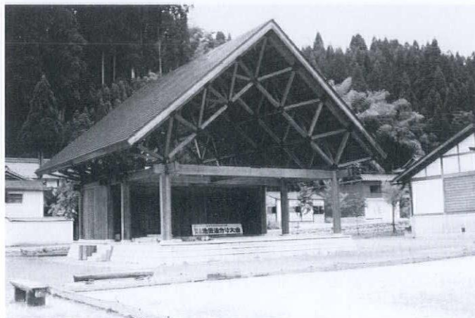
1. 福井県池田町（多目的ホール）
