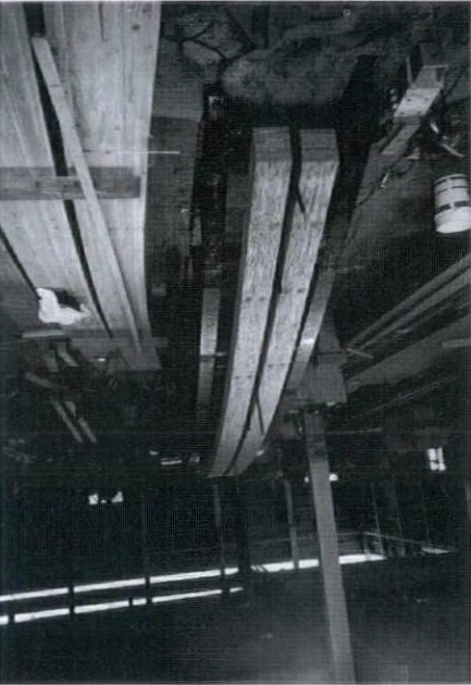
新宮健康増進センター(和歌山県新宮市)/設計：古橋建築事務 所
