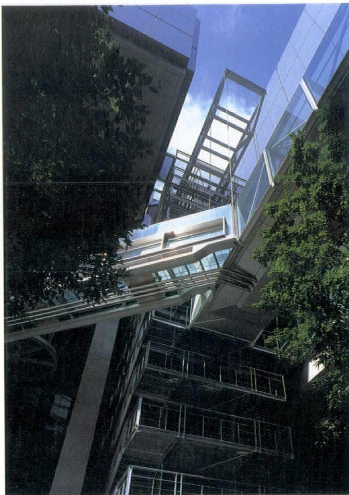
C、D棟間の外部壁離階段とガラスホール連絡ブリッジの見上げ
