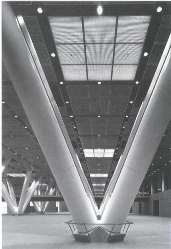
展示ホールV字柱。柱はGコラム鋼管内にコンクリートを充填しさらに耐火被覆としてFL+3000までをコンクリート巻、その上部を曲面ケイカル板巻とした。V字柱上部天井は光天井とし、ブラザからの自然光が入るイメージを作っている
