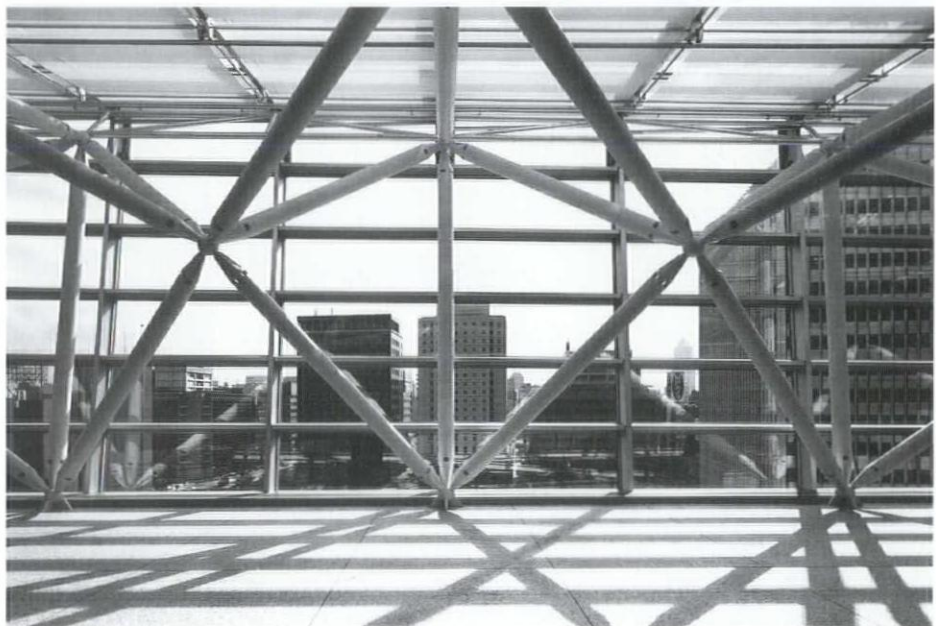
半径360mの曲率平面と3次元的に変化するスタートラスの構成が空間をダイナミックに演出する
