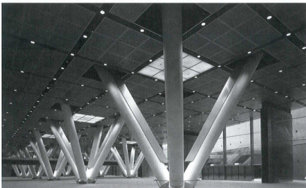
展示ホール内部。敷地中央ブラザ下、地下2階、1階の吹抜部に設けた展示ホールは周辺のコンコースと空間的に一体となるよう配慮し、圧倒的なマスをパブリック空間の中に融和させることに成功している。特徴的なV字柱は地上の9mグリッドの構造スパンを、18mグリッドに変換し、展示ホールのスペース効率を上げている
