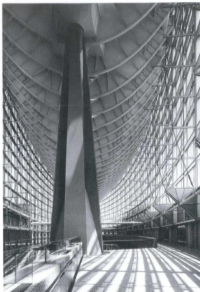
ガラスホール大柱。応力に応じた柱の太さを立体的に表現した
