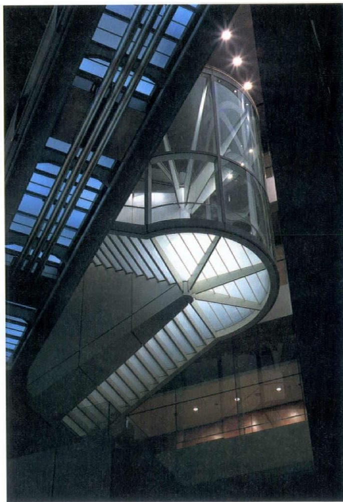
D棟4階と5階を結ぶ客用階段とブリッジの床を、乳白フィルムをはさんだ強化合わせガラスとし、夜間は空中に浮遊するオブジェクトとなるようにデザインした
