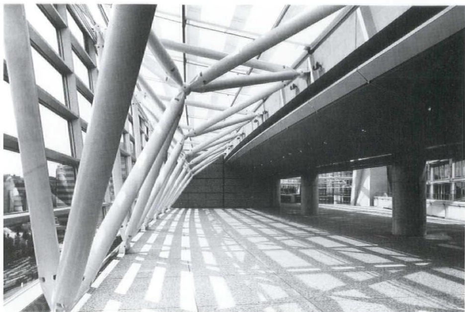
スタートラスを立体的に見る 午前中の直射日光を遮る為、屋根壁ともにロールブラインドが組み込んである
