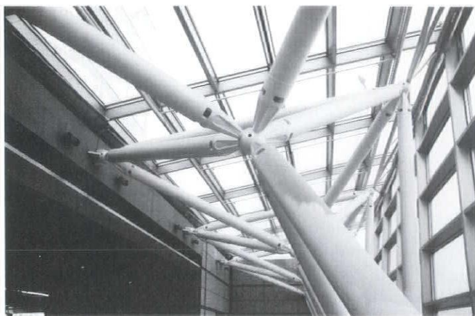
スタートラスの見上げ。ボールジョイント部のリデューサーは鋳物。鉄骨はFR鋼を用い、耐火塗料で塗装してある
