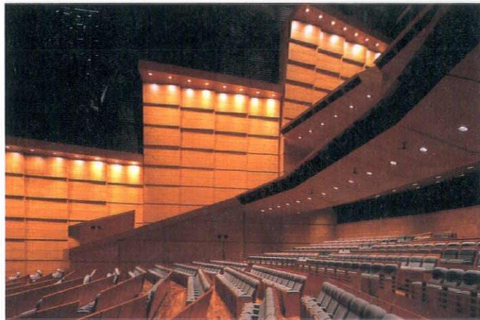
ウォールウォッシャーで浮かび上がる側壁。上部のスチールメッシュユニットの内側には角度をつけた反射面を設けているが、暗色塗装されているので認識できない。会議時にはメッシュと反射面の間に吸音シャッターが降下し残響時間を2.1秒から1.2秒まで調節する
