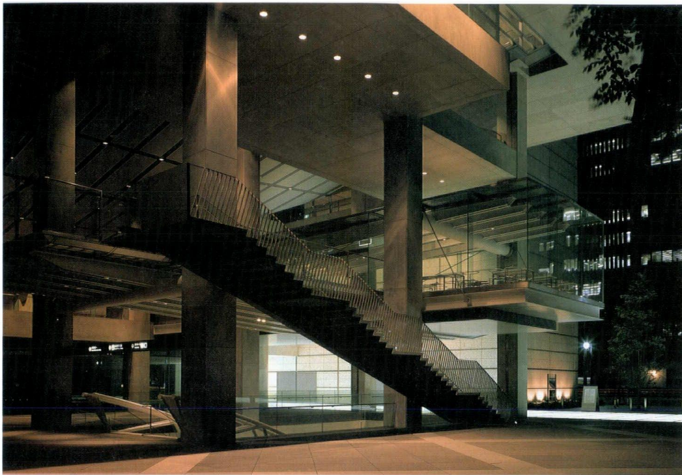
A棟2階カフェへ至る階段とガラスボックスのカフェ。柱から片持ち支持されたシャープな階段を昇り、ガラス床のテラスを通してガラス貼のカフェへアクセスする。構造体が明確に見え、方向性のはっきりした空間。
