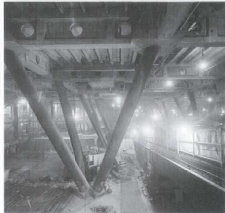
V字柱と1階床のPC床の施工
