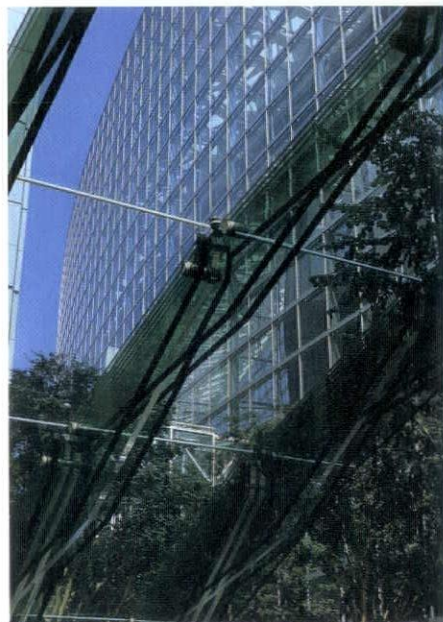
ガラス梁とガラス屋根の取り合い。ガラス梁の梁幅があるのでガラスであることの恐怖感はない
