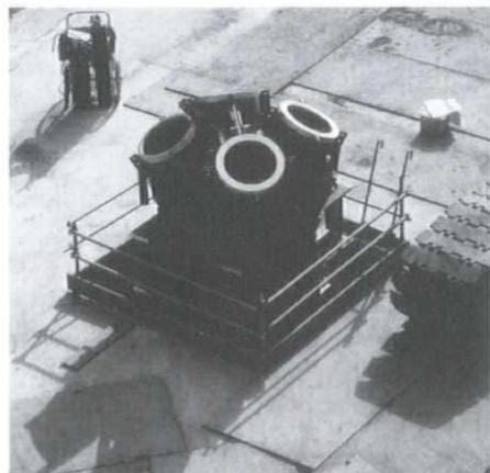
地下2階レベルで構真柱上に設置されたV字柱の柱脚
