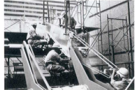
フェイルセーフの考え方から設計側が妥協し取り入れたアクリルプレート。ガラス梁が全て割れた時に瞬時に崩壊するのを防ぐ
