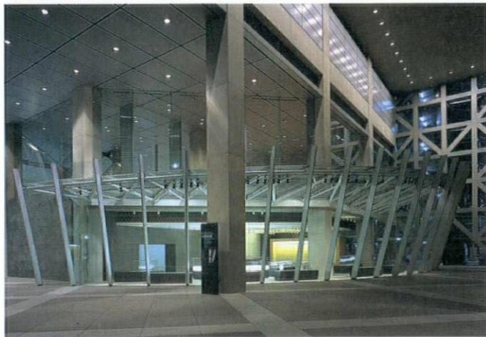
フォーラムショップ夜景。均等グリッドの構造に対し、傾斜したサッシュが3次的にからみ、プラザの演出となっている
