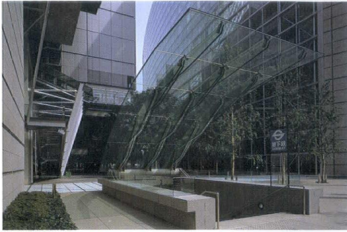
有楽町駅側のプラザ入口部で目を引くガラスの構造物。透明な構造物を追求した究極の解
