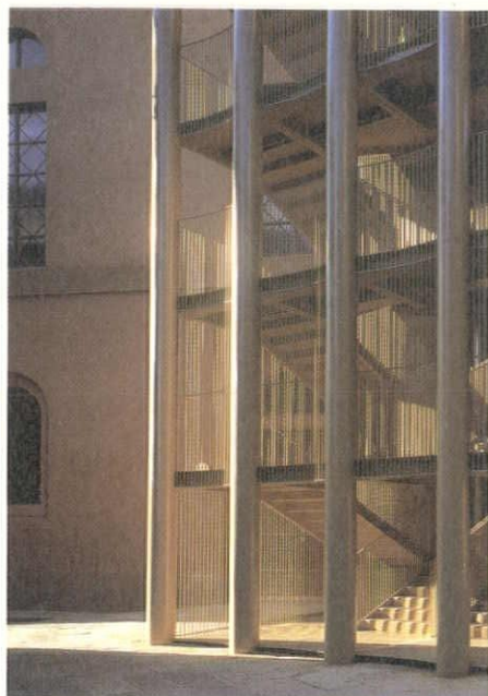
外部階段地上部分
