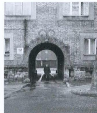
図-26 〈ヴランゲル通りの集合住宅〉 ヴランゲル通り12番地の住棟を貫く中庭への通路の入口門型のアーチによって1階の窓の配列が乱されている 写真=Stark
