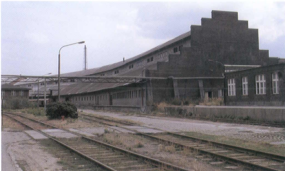
図-8 〈ルーパンの化学工場〉過燐酸が生産された棟。段状の妻壁が特徴的だ
