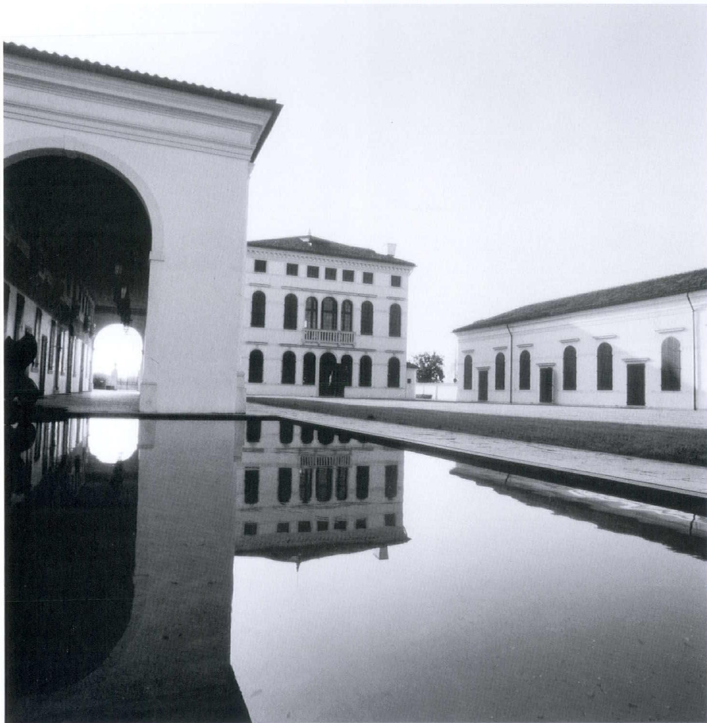
この改修に際してトピアは周辺に池を配した
