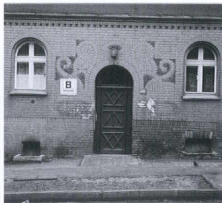
図-31 〈ヴランゲル通りの集合住宅〉 ヴランゲル通り8番地の住棟の玄関周辺の壁の煉瓦模様 写真=Stark
