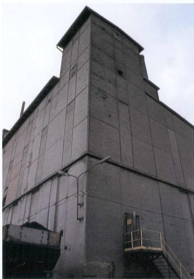
図-4 〈ルーバンの化学工場〉発電棟はガラスと煉瓦のカーテンウォールとなっている
