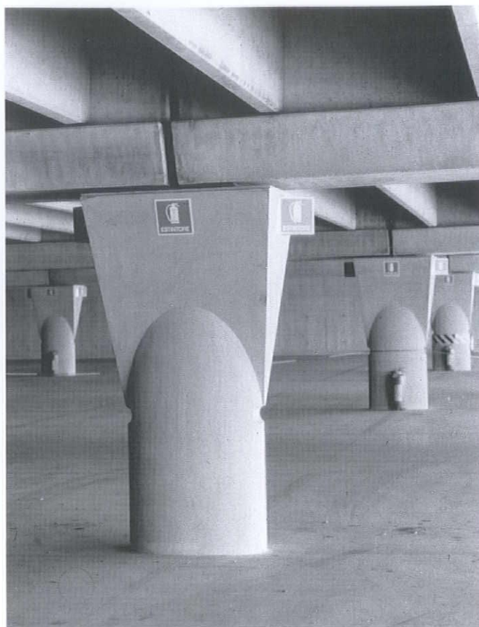
地下駐車場内部。この駐車場は敷地の中央に位置している
