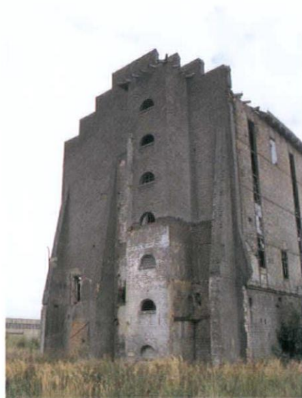
図-6 〈ルーバンの化学工場〉妻壁部分は煉瓦積層構造となっている
