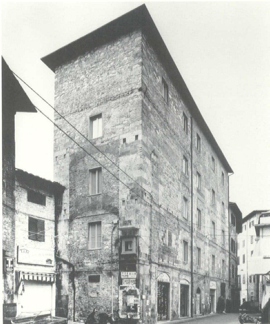
建物外観。外壁を覆っていた漆喰は取り去られ、中世の構造体が露出された
