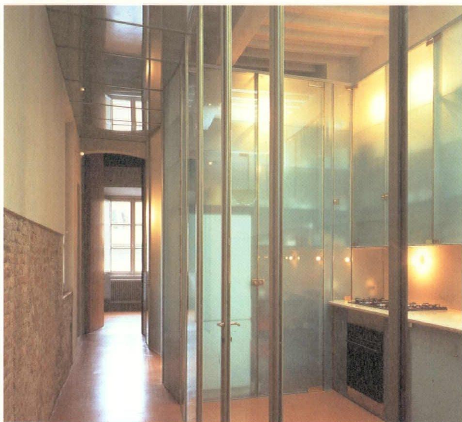
住宅A：台所 ガラスのパーテーションによる空間分割 SD9705 84
