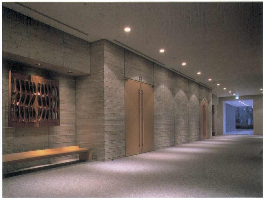
コンクリート打ち放しの出目地は鈎込まれたコンクリートの重量を際立てる
