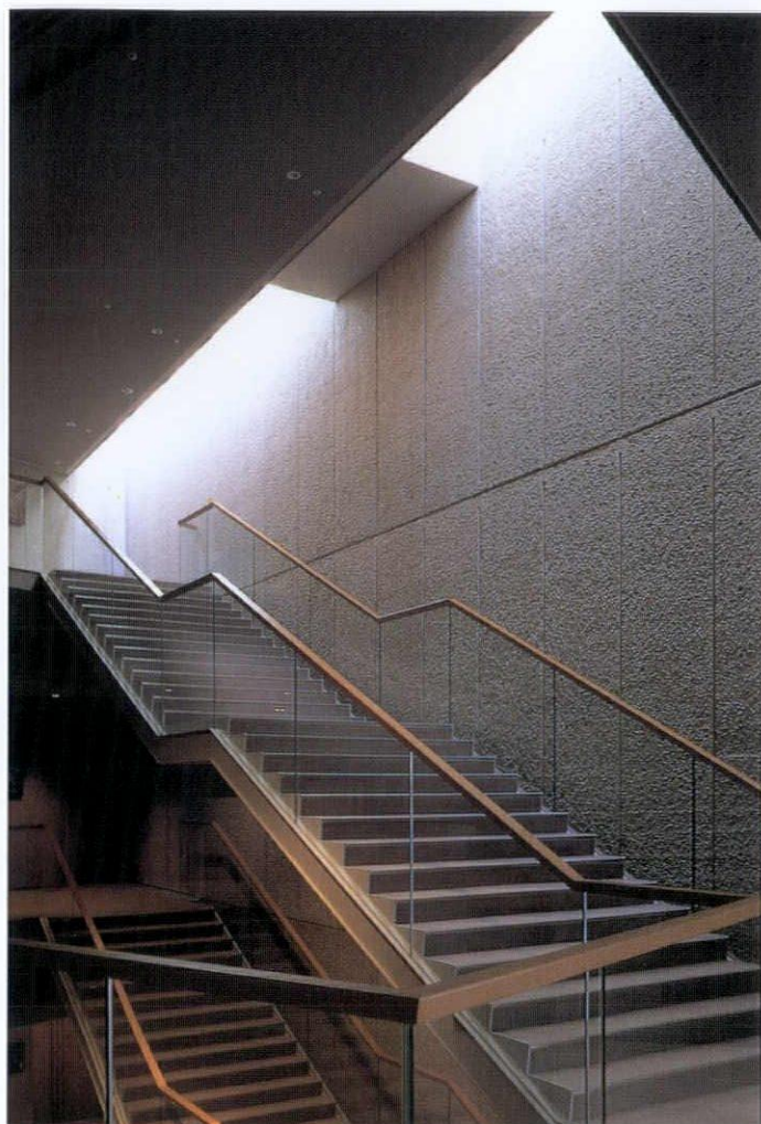
コンクリート打放し磨り仕上げは光を碎く影が構造的な力の表現を際立てる
