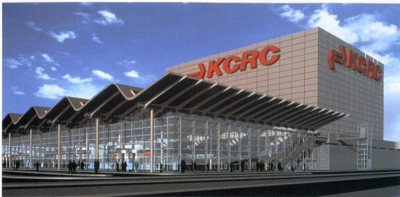
KCRC/九龍広東鉄道・九龍駅増改築プロジェクト
