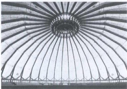
出雲ドーム(木造ドーム) 大空間に日本の伝統美を生かした木造とスチールによるハイブリッド膜構造。
