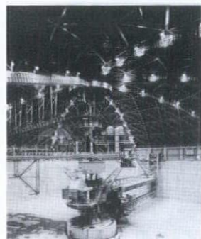
竹原火力発電所貯炭場内部(ラメラドーム) 安全性・経済性にすぐれ、あらゆる用途に対応できる鉄骨ドーム。
