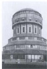
図31 ボーゼンの給水塔(外観) 1911年 作者=ハンス・ベルツィヒ 出典=「Industriebau」 1911年
