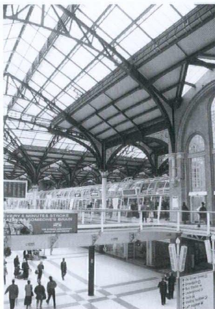
イギリス、リバプール・ストリート駅。装飾的な柱、梁による豊かな大空間に、新しくガラスのチューブ状のペデストリアンデッキが設けられ、より立体的なアトリウム空間を構成している
