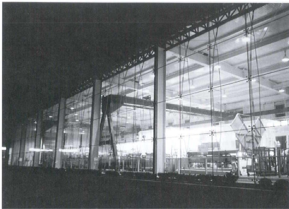
フィグラ本社工場外観(夜景): 透明感を演出する縦方向張力トラスと、サッシュレス構法のひとつである点でガラスを支えることのできるGRACY-xを使用した。昼間は外部を映し込み、夜間は内部を映し出す。縦方向張力トラスでガラスを支える。
