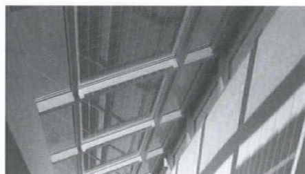
太陽電池ガラス屋根/多結晶シリコンモジュール
