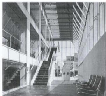
方杖を使用し、屋根荷重を支えるため、鉛直部材は方杖のスラスト力で断面が大きくなる。本計画では、屋根の施工後方杖を設置する方法を採用し、鉛直部材をスレンダーにし、ガラスの透明感を増大させている。
