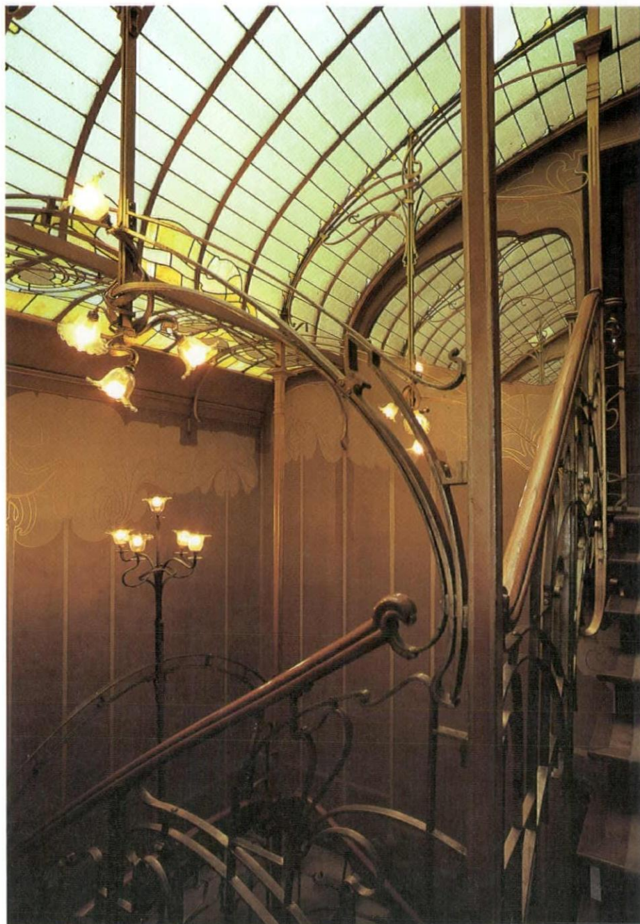
オルタ邸、1901年、ブリュッセル、鉄の架構が、スカイライトばかりが踊り場までも吊っている階段室。
