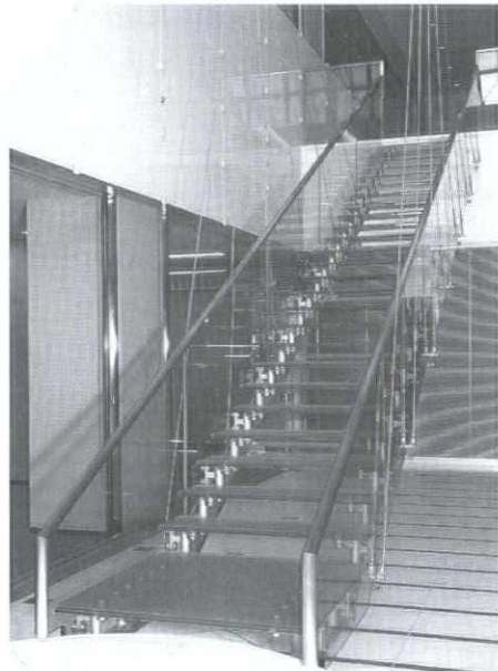
横浜倉庫ベイサイドビルガラスの階段 ガラス：30mm、ラミベーン（透明強化合わせガラス）
