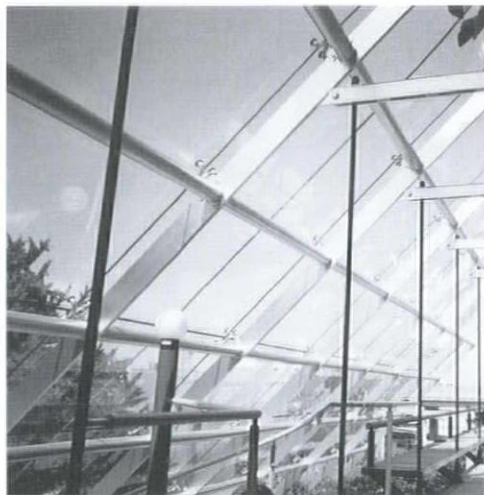
ルーフトラスの架構を形態利用することで、ルーフを支えるフラットバーをスレンダーにした空間。
