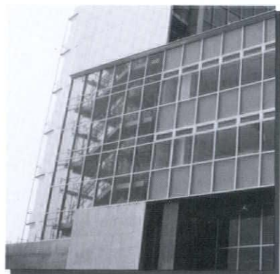
①乙種防火戸用ガラスとして (通則認定サッシとの組合わせ、または個別認定の取得)
