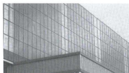
太陽電池カーテンウォール/アモルファスシリコンモジュール
