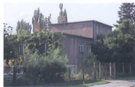
WUWA Haus 28 : E.ランゲ 1929年、現在の外観
