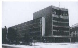
図6 ベルリン金属労働組合会館、1928-30年、設計＝エーリヒ・メンデルゾーン
