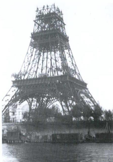
エッフェル塔建設途中(展覧会カタログより)
