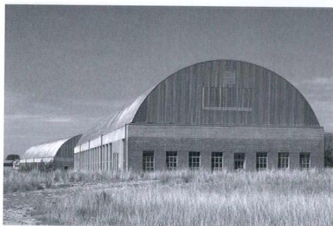
〈チナティ・ファウンデーション〉「弾薬庫」。コルゲート板のヴォールト屋根はジャッドによる
