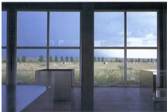
〈チナティ・ファウンデーション〉「弾薬庫」の開口部。ジャッドは4:5の比例を好んだ
