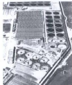
ノーザン・アウトフォールの下水処理場
