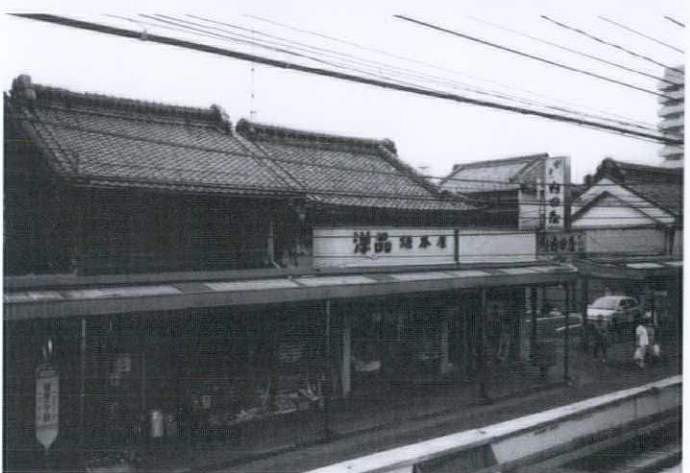
所沢駅前商店街の保存状態の良い蔵造りの町並み
