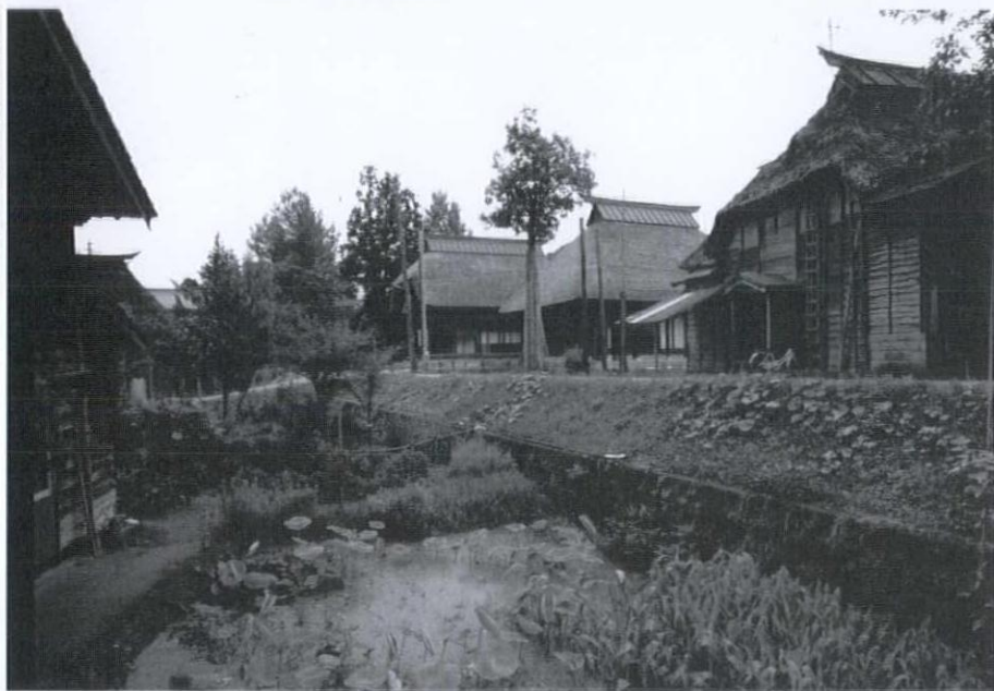
高柳町荻ノ島地区「荻の家・島の家」。茅葺き民家の改修1棟、移築再生1棟、新築の茅葺き2棟、計4棟の設計監理を日影が行った
