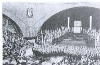
図8 〈世紀のホール〉での博覧会のオープニングセレモニー。 4つ設けられたアルコーブのひとつに仮設ステージを組んで行われたオープニングのセレモニー。アーチがプロセニウムの役割を果たして、そこからステージが迫り出しているような印象をうける。
