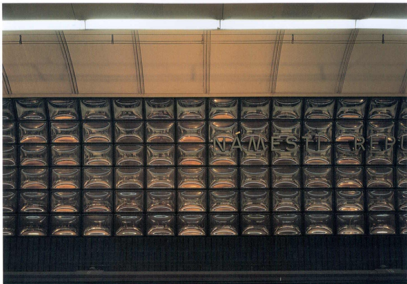
ナーメスティ・リパブリキ駅のホーム。凹面のガラス・ブロック壁面
