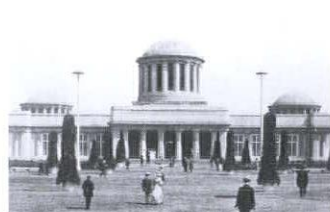
図7 〈歴史展示館〉H.ベルツィヒ 竣工当時(1913年)の外観 ハイサイドライトのための小さなドームが4本設けられていたために、通称「4つのドームのパビリオン」といわれた。建設費が厳しく柱梁はRCだが、壁は煉瓦積モルタル仕上げである。
