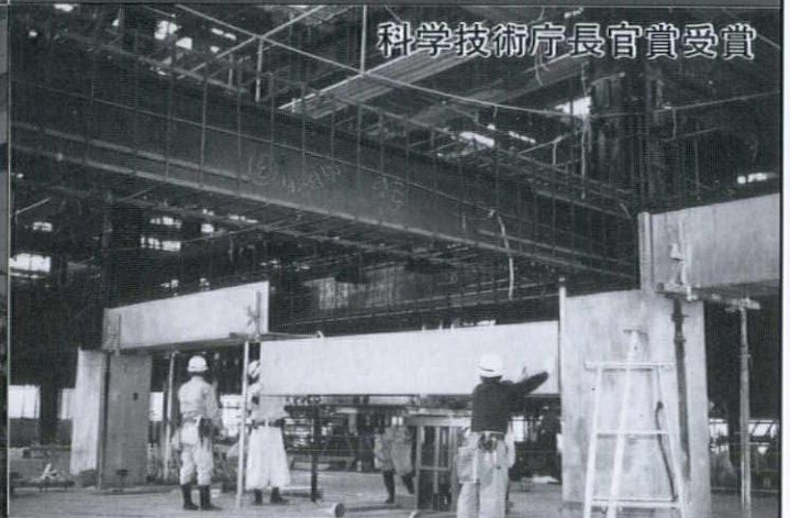
ペカ型枠 (独立柱・地中梁・二重ピット用)
