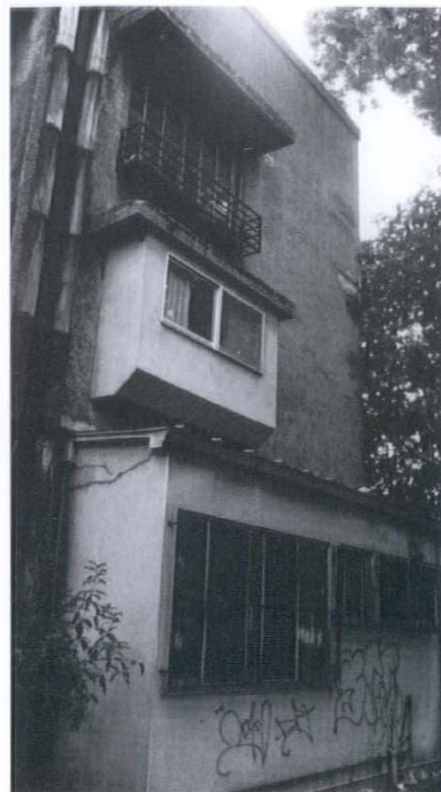
3階建住棟の増築の例。3階の窓は当時のまま、2階は出窓が増築され、1階は1室が増築されている
