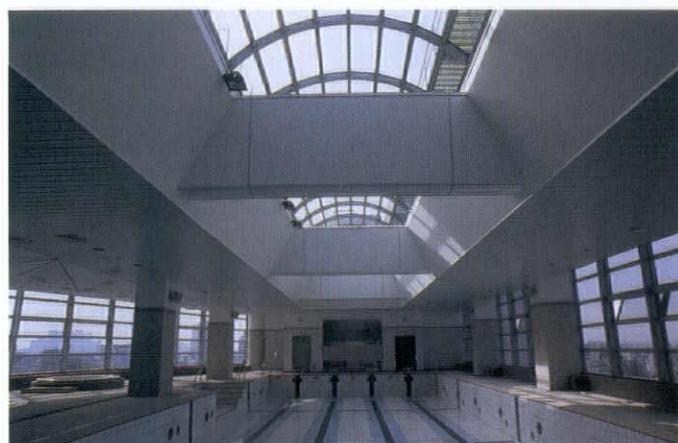
温水プール：清掃工場の余熱を利用した温水プール。最上階に位置し夏季にはトップライトによる換気が可能である。ほぼ南北面に開いた開口部は省エネを考慮すると共にサンシャイン等の池袋の中心から都心方面と埼玉方面の眺望を確保している
