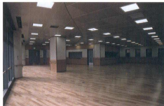
2階機能回復訓練室:高齢者のための施設である在宅サービスセンターは優しさとともに安全性も要求される。そこで壁には水性アクリル系壁紙と木質系の腰パネルを使用し暖かみと手触りのよさを出している。床はクッション付き天然木フローリングを使用している
