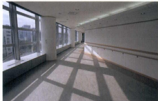
6階ロビー：各階機能異なった施設であるが、共用廊下は全て共通の仕上げ材で構成し統一感を持たせている。床に天然リノリウムシートをライン状に張り分けて使用し、壁はポリオレフィン系の壁紙を使用している
