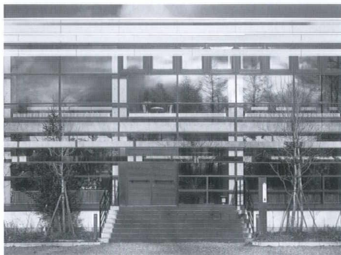
オフィス・工場棟エントランス
