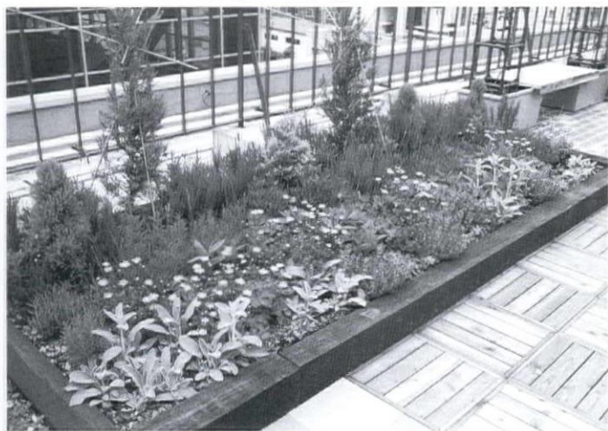
植栽基盤厚20cmでのハーブやコニファー類の栽培
