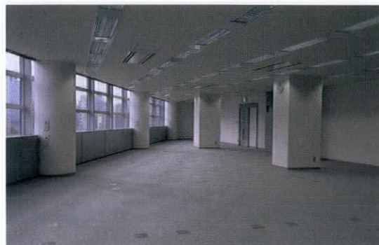
4階清掃工場管理事務室：床下配線の必要な事務スペースには床にゴミ焼却灰を利用したOAフロアを使用している。さらにポリオレフィン系タイルカーベットの裏に使用している。壁は再生パルプを利用した壁紙を使用している
