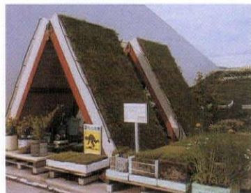
(c) 4年目5月 (植栽率100%) 図3: 60°の急斜面に植栽した芝の生育状況 (植栽率: 植物で覆われている面積比率)
