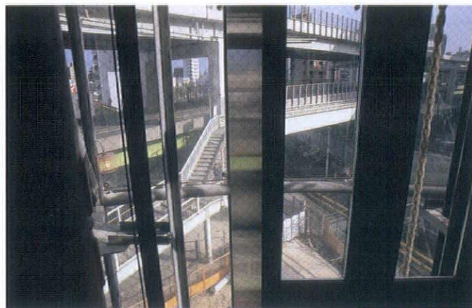
DPGガラスによるエレベーターシャフトを持ったシースルーエレベーター:北東角にガラス開口を配置することにより、シャフトへの熱負荷をおさえている。山手線、川越街道の交差点部分に面するためダイナミックな都市の動きに新しい縦の動きを加えることになる
