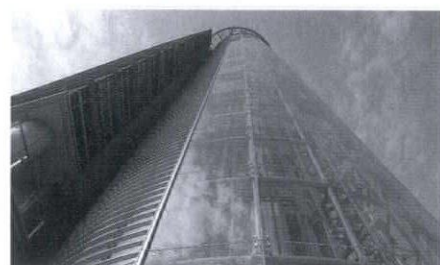
エレベーター・シャフト
