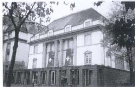
ドイツ建築博物館(DAM)／O.M.ウングース設計、1984年開館
