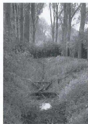
デルビガー川の改修では川道を並行移動させた区間がある。この写真は改修後、本流でなくなったが撤去されない状態に残る古い水路。右側の写真は自然型改修後のデルビガー川
