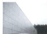
北側の壁面には必要最小限の窓しかない
