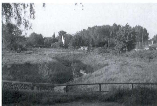
レップケス・ミュレン川における自然型の水路改修
