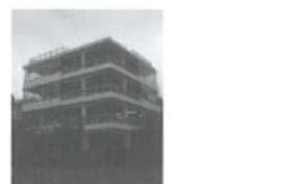
M | J. Duiker 外気開放小学校 | 1930 Open Air School 1930 Cliostraat 40 Amsterdam
