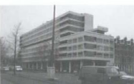
H | H. Hertzberger 学生寮 | 1966 Student's House 1966 Weesperstraat 7-57 Amsterdam
