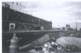
整備中のRoute9AとPier40東面
