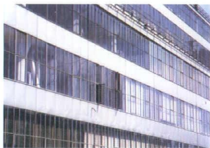
ファン・ネレ工場の外壁
