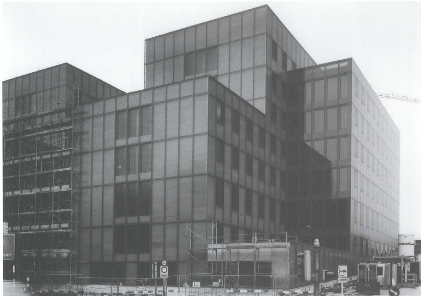
最近の現場写真。コンクリートの外壁の外側にさらに緑色の焼き付けガラスで覆っている。ジャッドの指示によって、両端は劇的な演出が避けられ、ヴォリュームと中間領域の規則的な交替のみにとめられている。 photo: Hans-Jörg Walter
