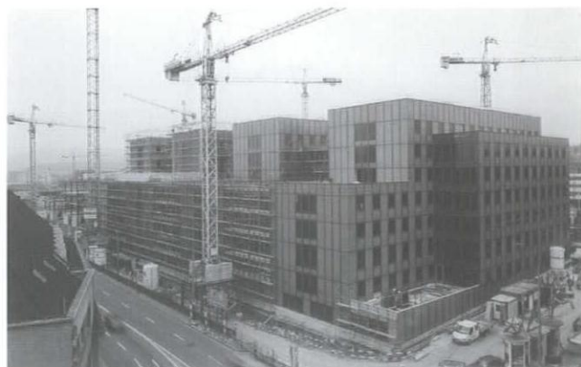
最近の現場写真。コンクリートの外壁の外側にさらに緑色の焼き付けガラスで覆っている。ジャッドの指示によって、両端は劇的な演出が避けられ、ヴォリュームと中間領域の規則的な交替のみにとめられている。 photo: Hans-Jörg Walter
