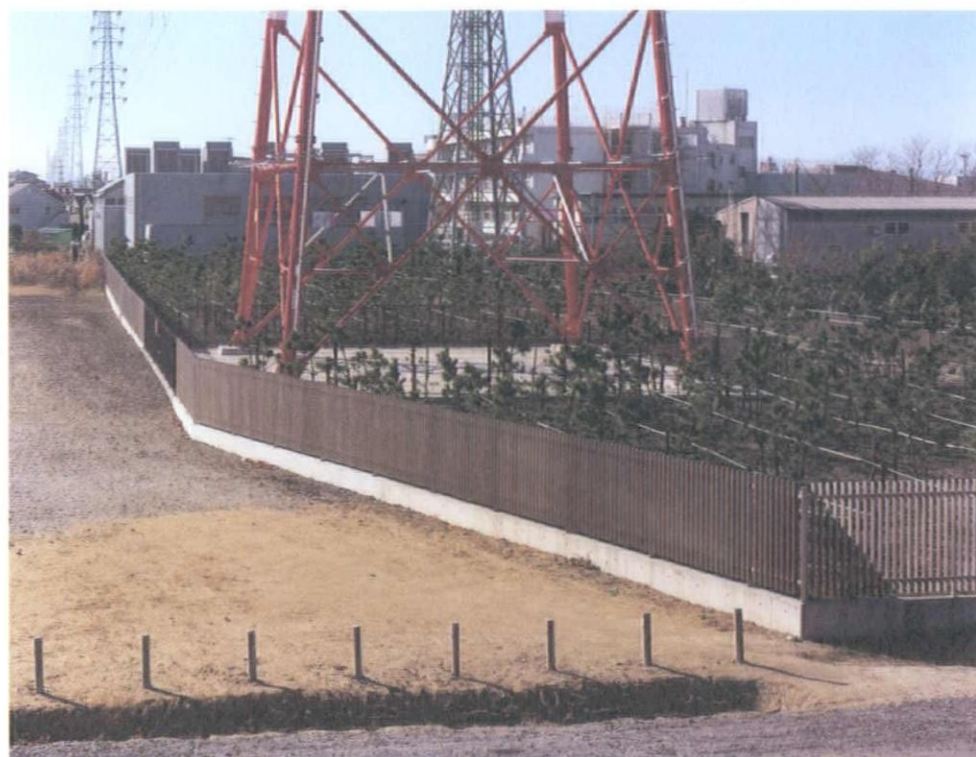
photograph 1: 荒川河川敷の都民ゴルフ場ショートコース。北区豊島付近 / photograph 2: 荒川河川敷。足立区鹿浜付近 / photograph 3: 足立区鹿浜付近の送電鉄塔
