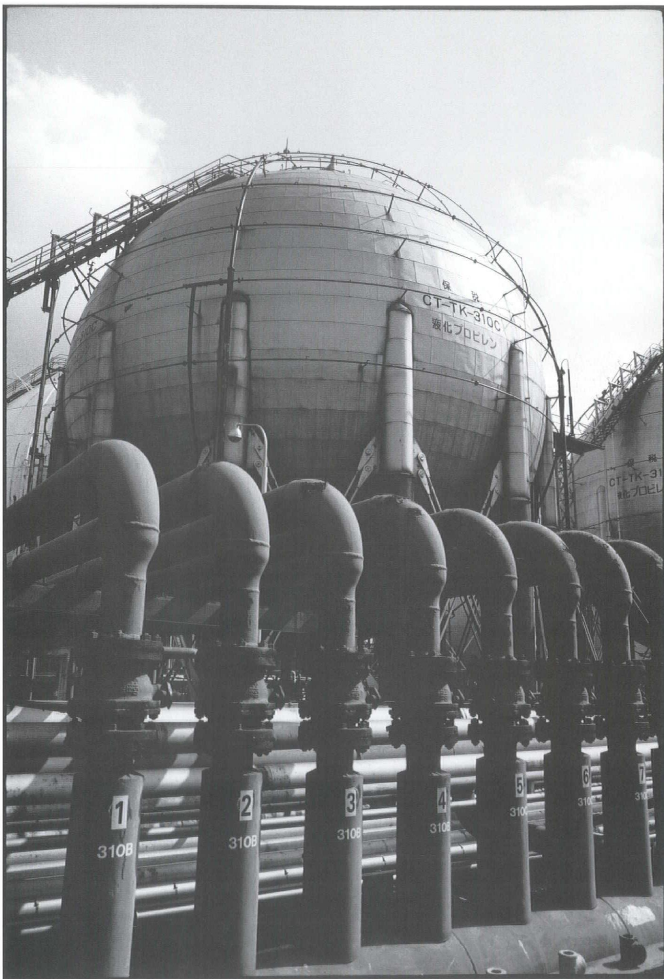
液化プロピレンタンク。生成の過程でポリプロピレンは気体・液体・固体の3相の間を転ずる。
