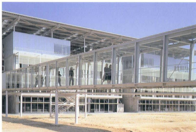
教室棟と芸術棟を結ぶブリッジ
