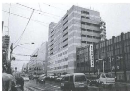
特別養護老人ホームと複合化された公立中学校 (東京都戸越台中学校)
