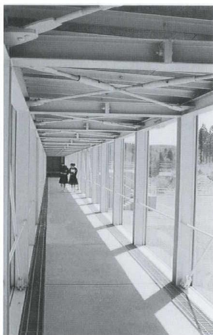
芸術棟と教室棟を結ぶブリッジ
