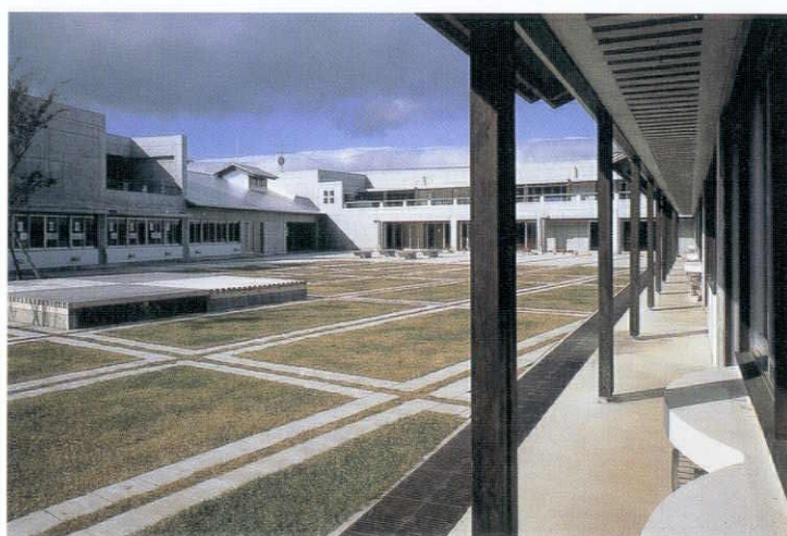
柱廊から中庭を見る
