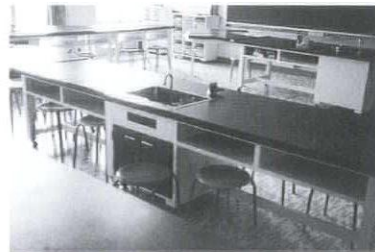
床のコンセントビッドに連結して用いる可動流しテーブル (富山県福光東部小学校)
