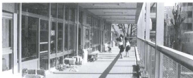
教室前面の広いバルコニー（東京都杉並第4小学校）
