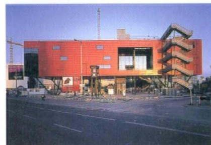
インフォボックス。工事中の広場を一望できる展望室
