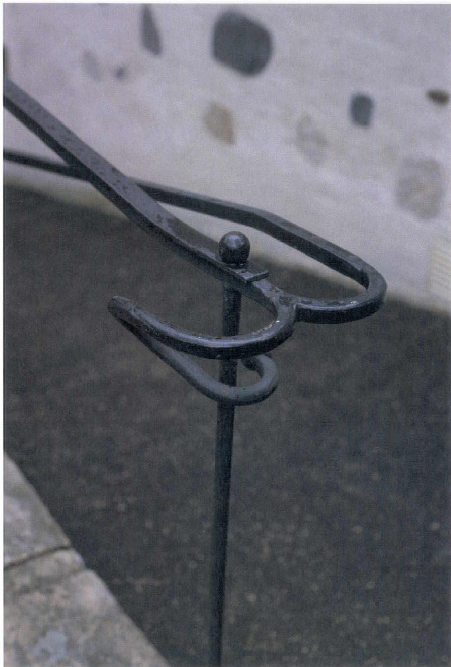
1. 雲安室へアクセスするスロープに施された鍛鉄製手すり
