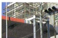
鉄骨フレームとの接合
