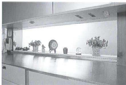
食器棚の引き戸は、3mm厚のアルポリックに引き手としてアルミアングルをビス止めたものを溝に落とした。軽く使い勝手が良い。またテーブルの手前は固定、向こう半分は高さを変えることができる。
