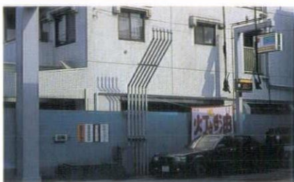
隣地に配慮した可燃性蒸気回収装置の独特な形態
