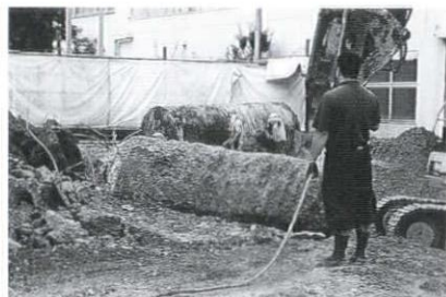
地下タンク撤去の工事風景
