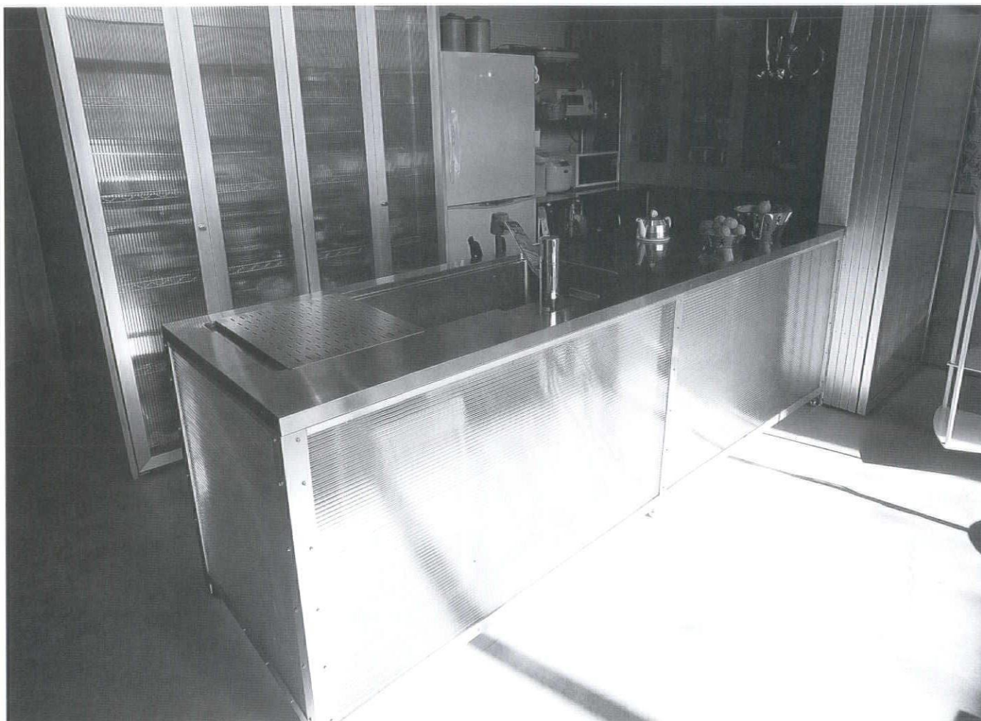
オープンな業務用をそのまま使うのではなく、ポリカーボネイト複層板を使って目隠しにするなどしている
