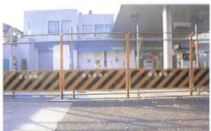
無骨な工事用フェンスで囲われた状態
