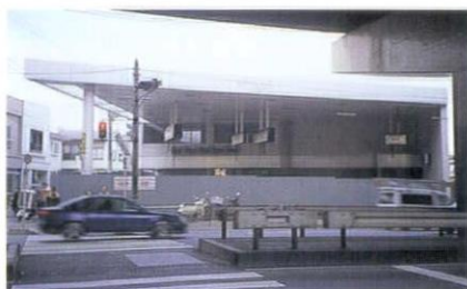
金属波板フェンスで閉鎖的に囲われた状態
