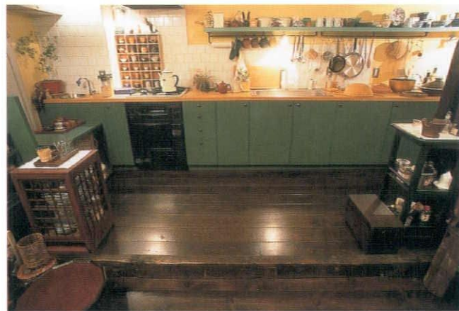
配水管を通すため床を上げている。左隅には造りつけのカウンター
