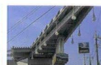
天井から吊された 懸垂式固定給油設備
