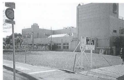
撤去工事終了後の更地風景
