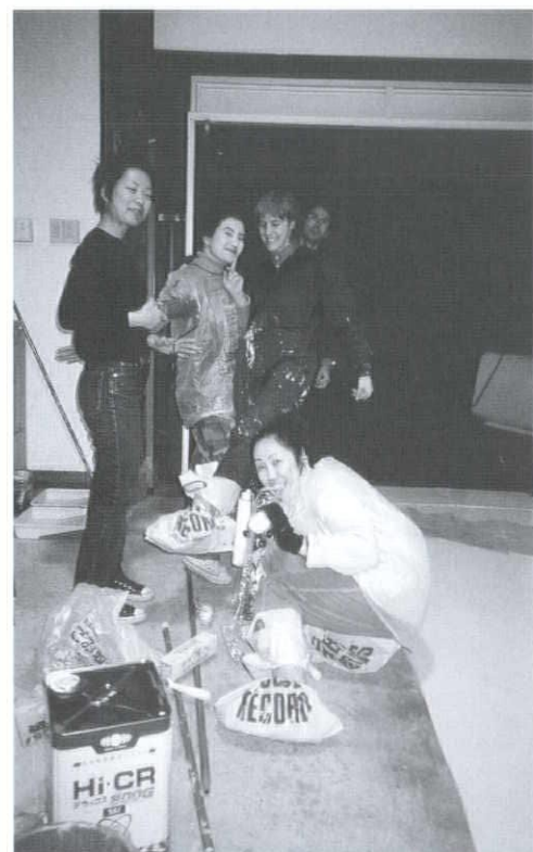
入居後1年経って打ち放しの床も大分汚れが目立ってきたので思いきって塗装した。ビニール袋の即席作業服を着て、大騒ぎしながらみんなで塗った。
