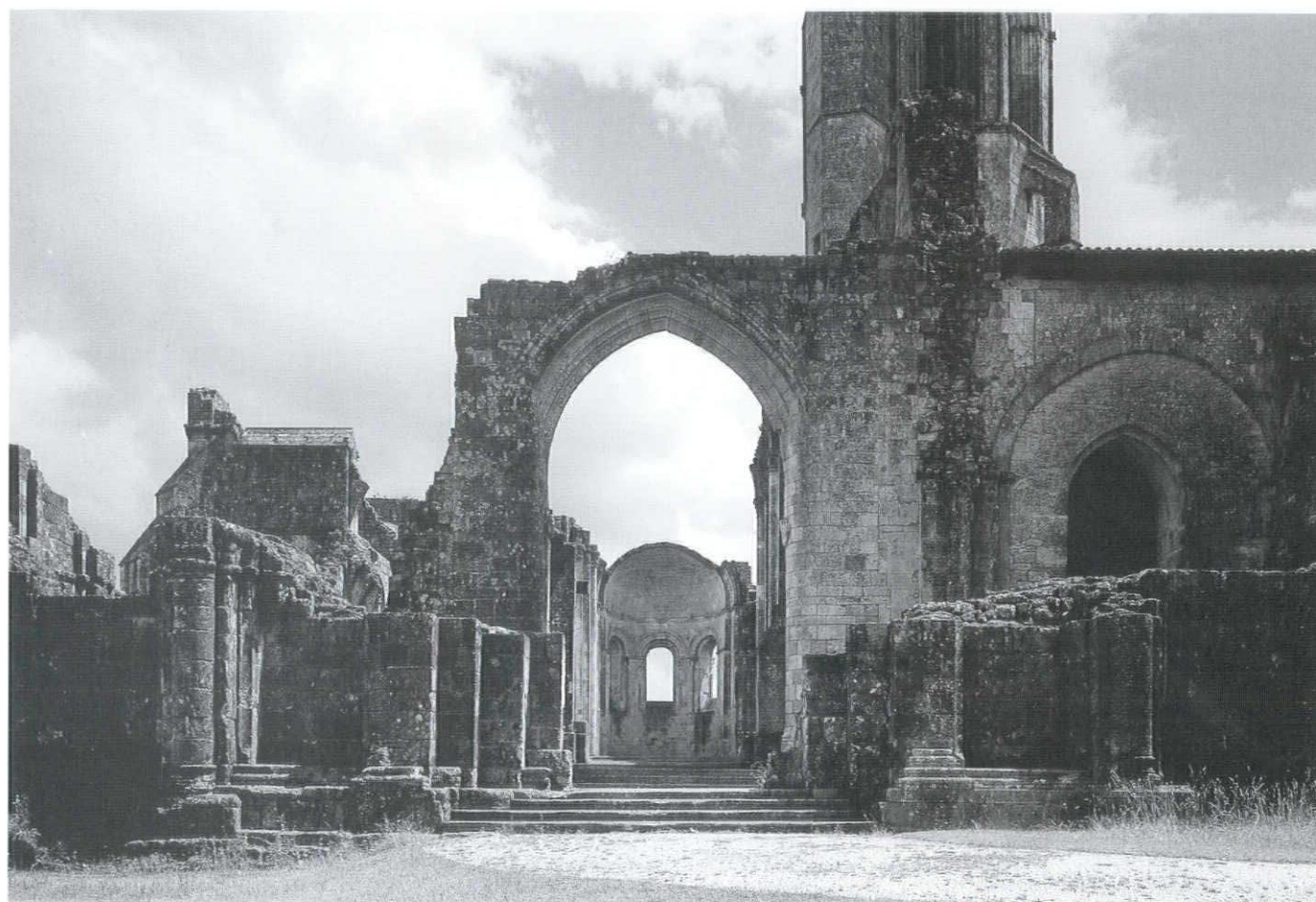
入口より身廊の軸線をみる
