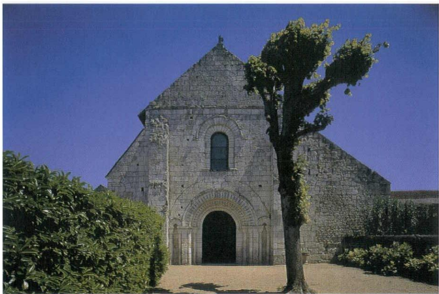
正面ファサード。側廊は現存しない
