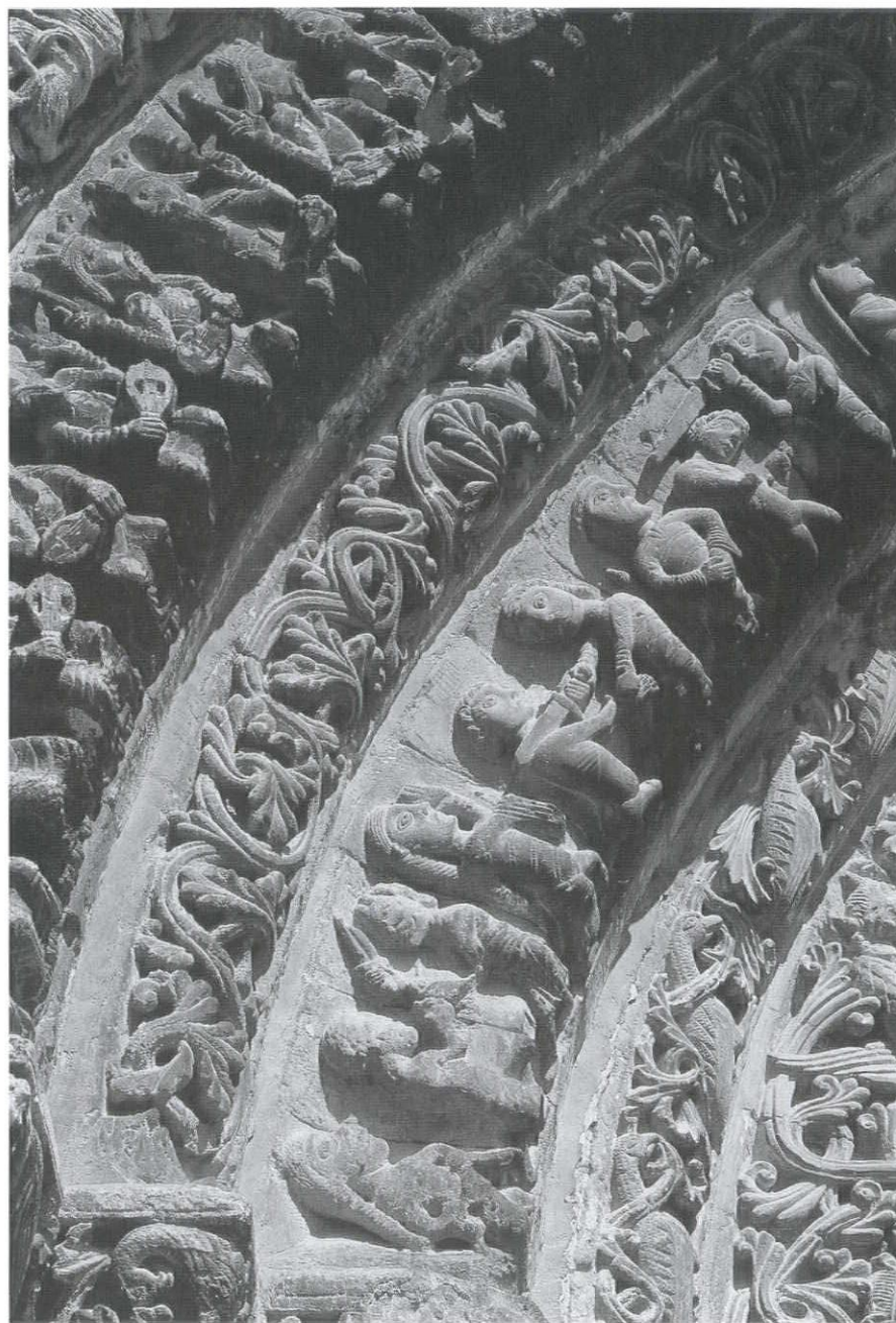
西ファサード正面入口上アーチ詳細
