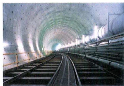
第2工区、シールドトンネル内
