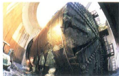
第4立坑内、マシン到達状況
