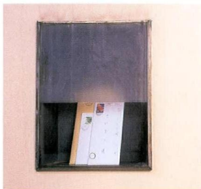
同上（内部）。ガラスの蓋により郵便物の到着が目瞭然
