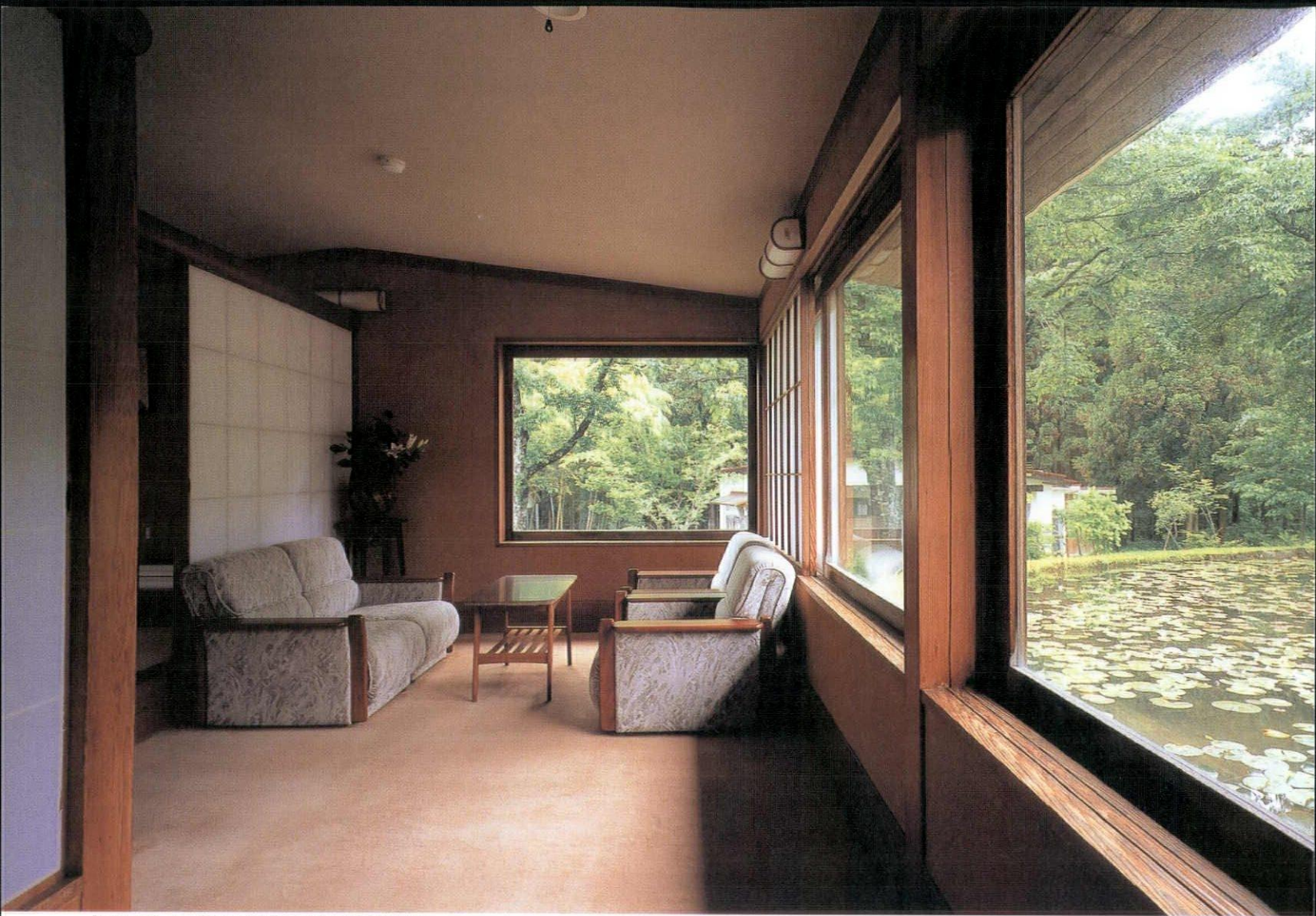
「杉亭」内部。太い部材と大きな開口を特徴とする真壁式大壁
