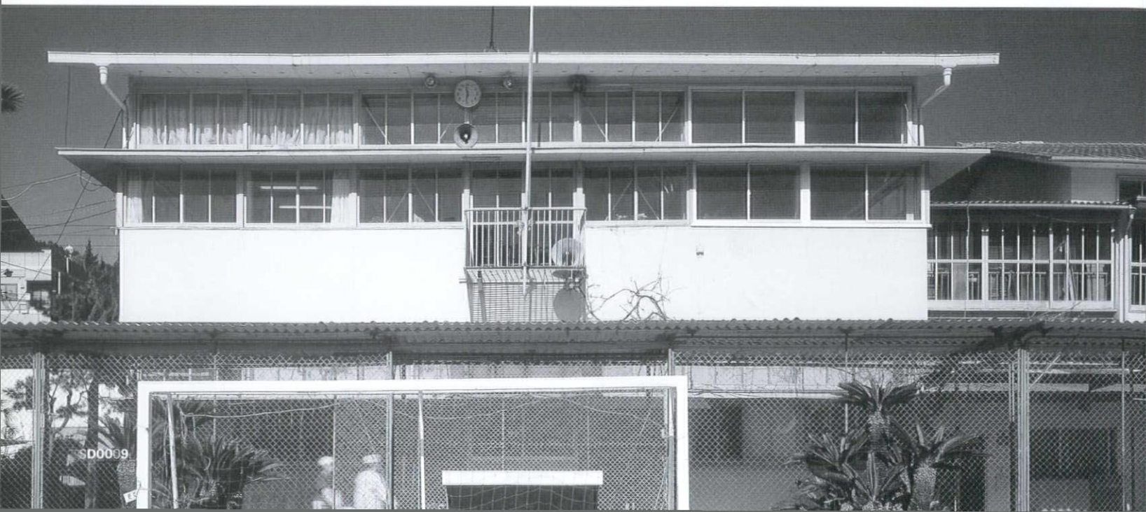
職員室棟の外観
