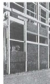
同左、工事途中、外壁の施工手順
