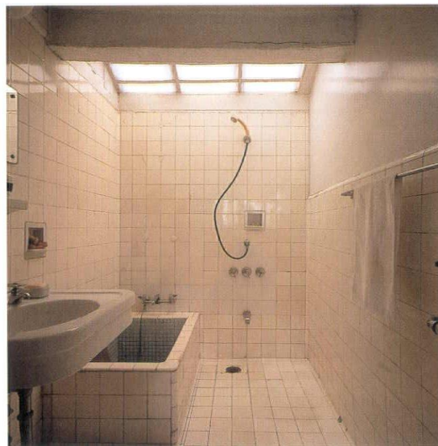
温水暖房システム用ボイラーを活用して湯が沸かされた浴室
