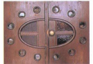
聖堂入口扉のディテール
