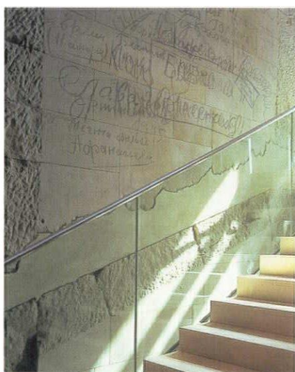
Wallots設計の19世紀の階段室吹き抜けは、1960年代の再建時に階段が取り除かれている。その跡が、新しい階段脇のガラスの向こうに見える
