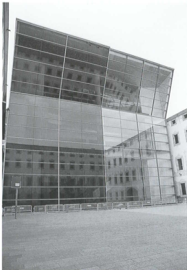
中庭に増築されたエレベータおよびエスカレータ室。左右ガラスと中庭の床パターンを変えている
