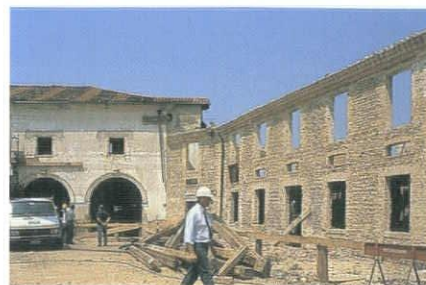
修復工事中の既存の構造物
