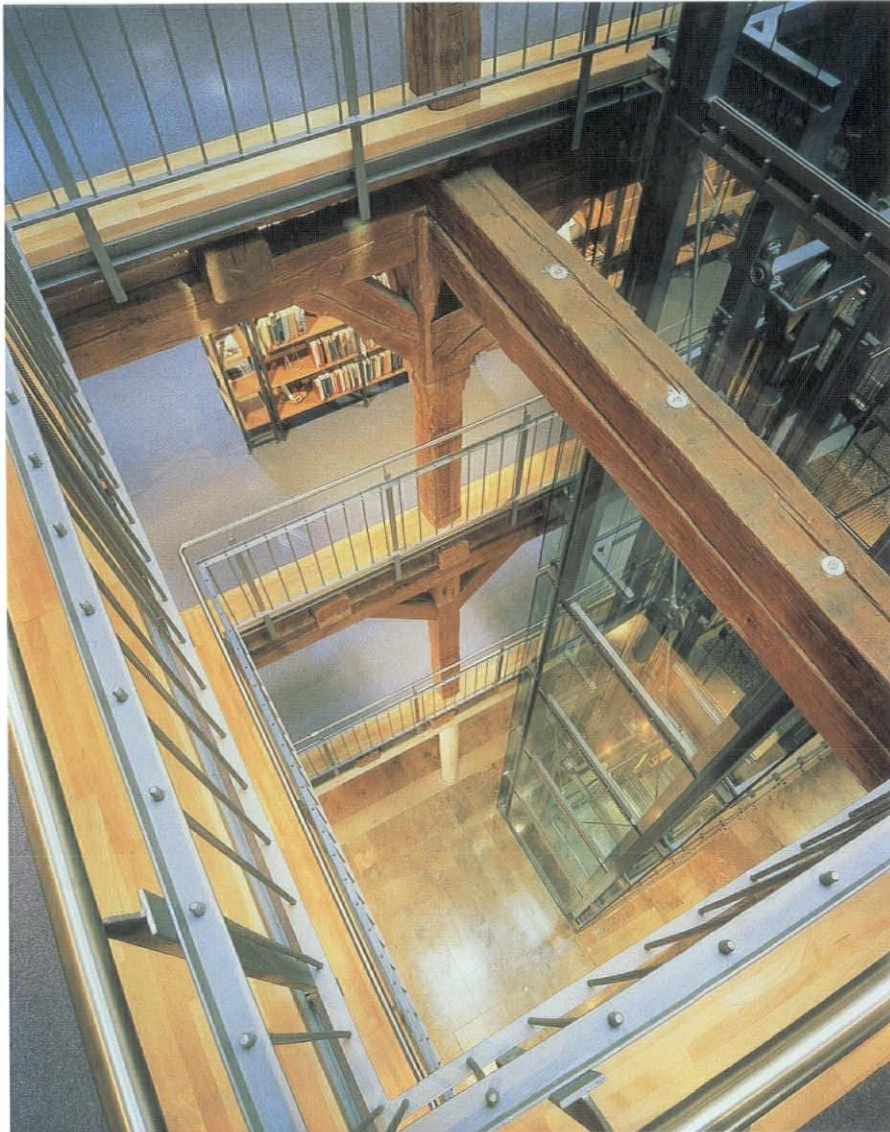
ガラスのエレベータシャフトと、既存の6階建て木構造とのハイブリット
