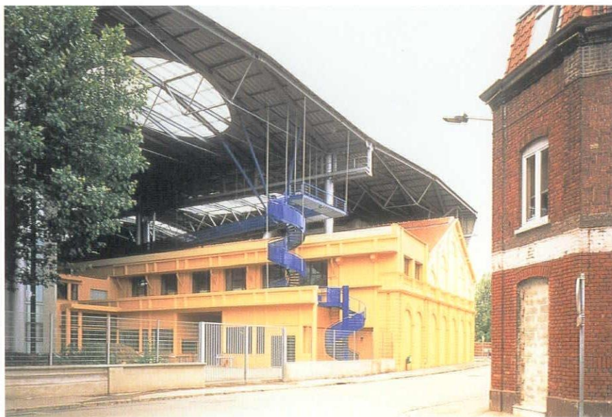
既存の建物（イエロー）、大屋根（シルバー）、間の動線システム（ブルー）とによって再構成されている
