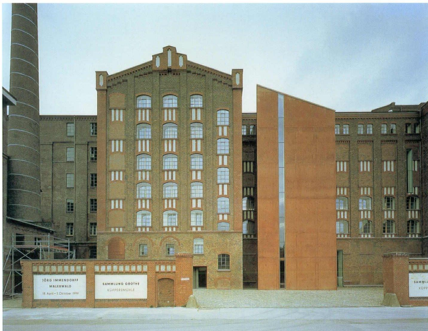
入口側立面。既存の建物の切妻屋根の角度を延長して増築された階段エレベータ室
