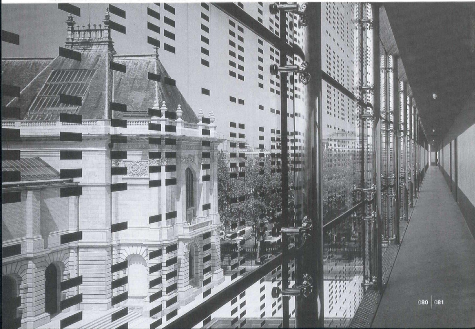
増築棟の内観とガラスのセリグラフィ。バックマリオンを鏡面仕上げにしているのは、表から見たときの透明感をできるだけ上げるためである
