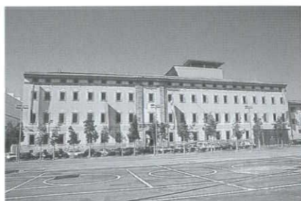
クラシックな外観は修復された。中庭に増築した部分が上部に顔をだしている
