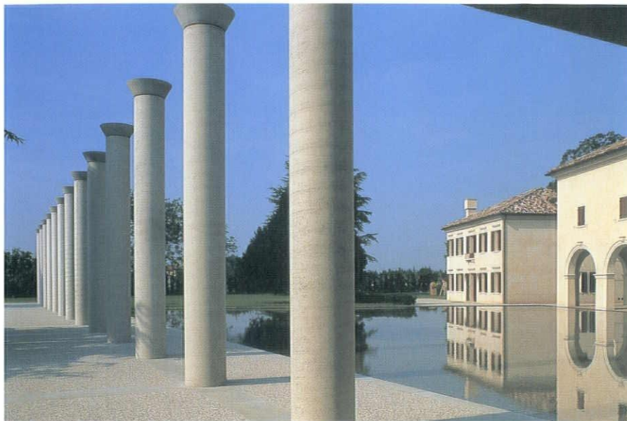
新しい列柱と既存の建物
