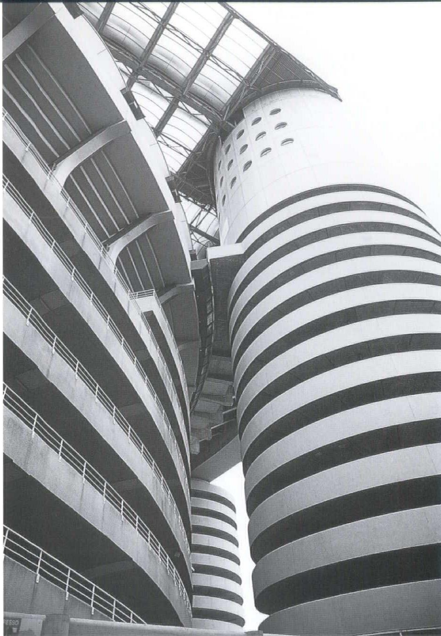
1956年の外壁部分（左）と1990年の構造部分（右）
