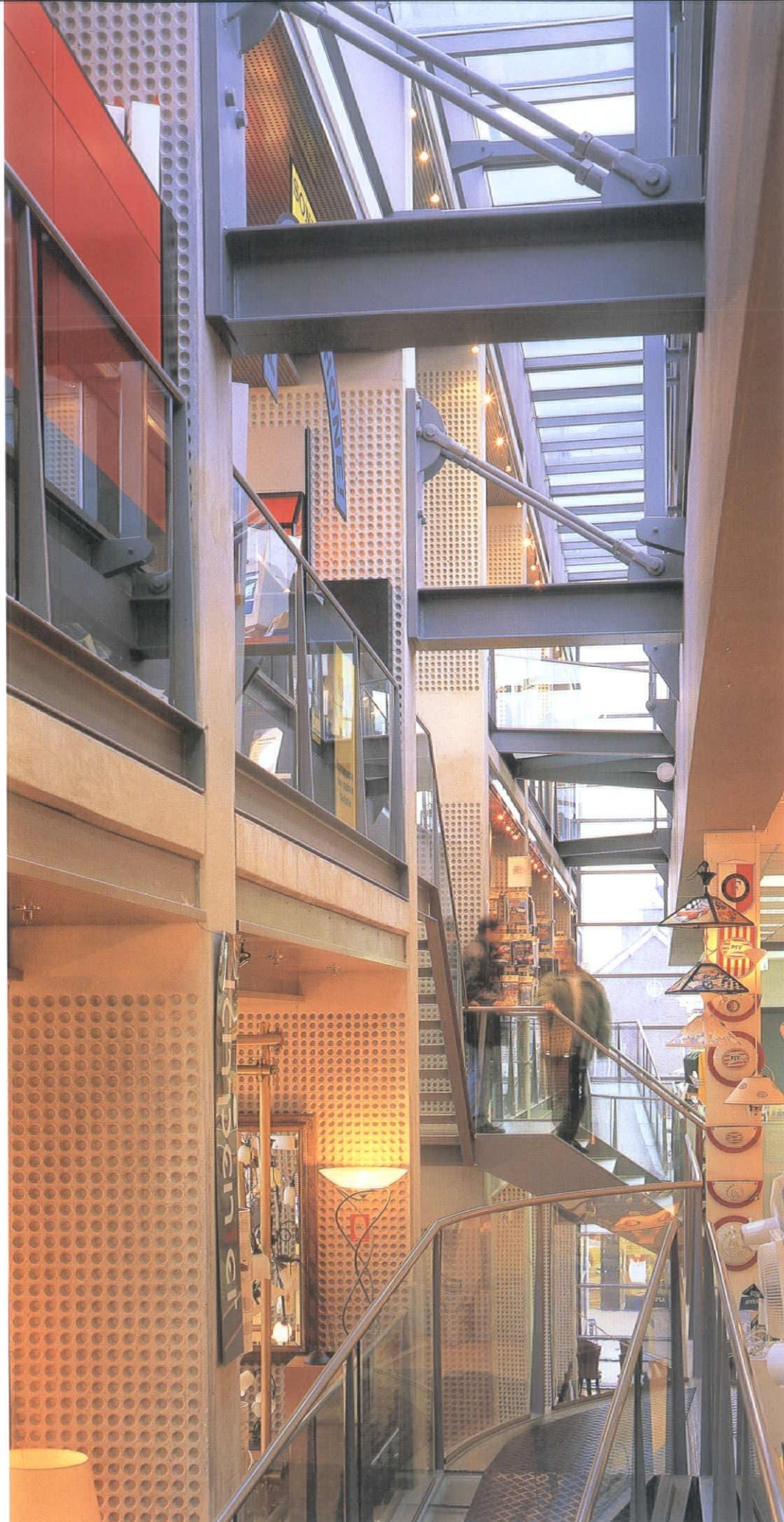
増築部分（左）と既存部分（右）との間に1.5mの隙間が開けられ、人、光、階段、スロープが交錯した立体的な空間が生まれる
