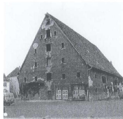
改造前の倉庫の状態
