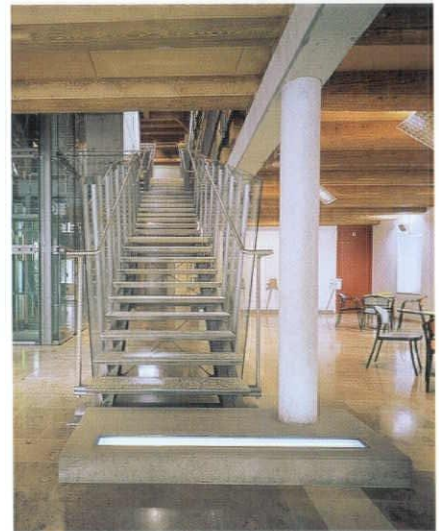
1階入口まわり。1階の木構造のいたみがひどいため、 コンクリート構造に置き換え、 上階の木構造を持ち上げている
