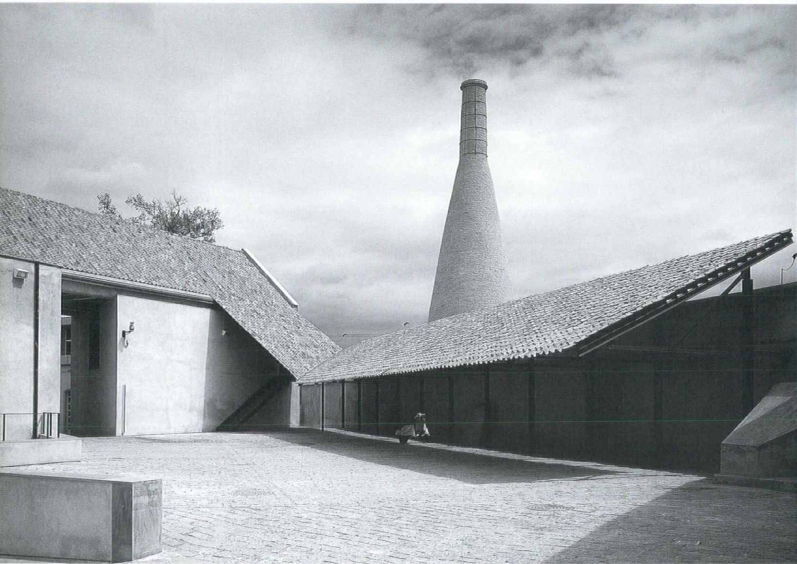
入口付近。既存の建物の瓦屋根が延長され駐車場の屋根に続いている。構造は鉄骨に切り替わっているが、屋根の素材が継続された
