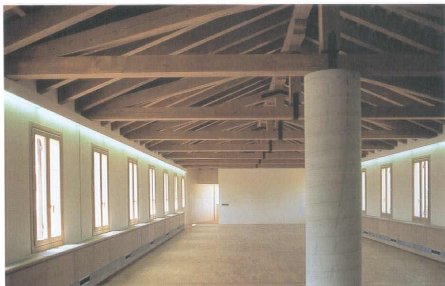
修復整備された内観
