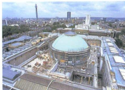
中庭に無秩序に増築された部分を撤去する工事
