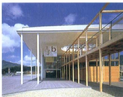
南東側から見る。 建物を貫通する桧の柱は構造的に独立している
