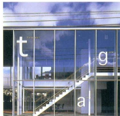
前面道路から建物を透かして奥の植栽が見える
