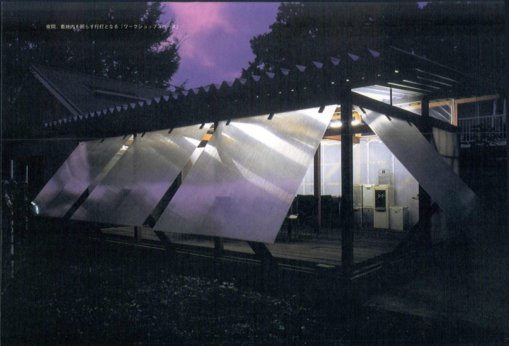
麻紐によるスクリーンファサードが施工された「メインハウス」
