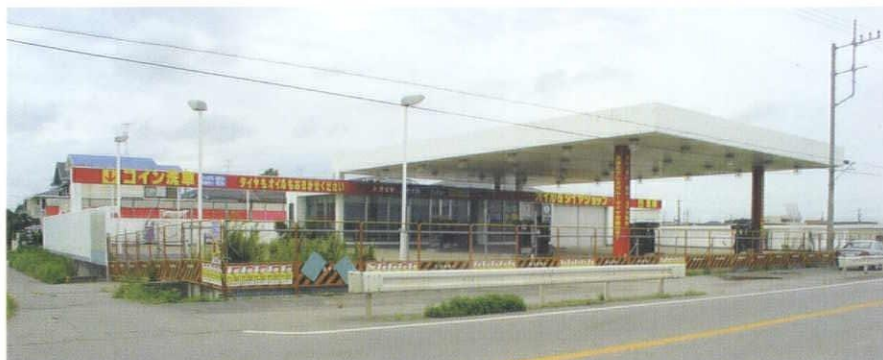
ジャケット撮影の舞台となった、閉鎖され放置状態のガソリンスタンド SD0012
