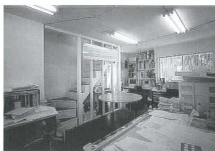
セカンドハウス：ネットワーク事務所等のワークスペース。無数の建具やユニットバスなどのサンプルが設置されていたサンプルルームであったこの場所は、壁・天井・床すべてを撤去し、ワンフロア化した。壊した壁に設置されていた電源スイッチなどを移設。LANケーブルや電話のケーブルをメインハウスから延長（担当：セカンドハウスリノベーションチーム）
