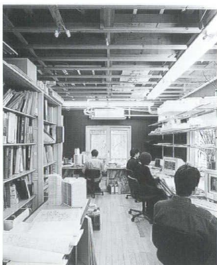
ワークスペース1：計9名のスタッフが作業している。既存の床・壁・天井・畳・収納・襖などを取り外し、ほぼワンフロア化した。通路との間仕切りは、建築資料やカタログ・サンプルの棚でおこなった。このスペースは、壁がコンパネや断熱材が一部露出しているところに黒の和紙を貼った（担当：1階リノベーションチーム）
