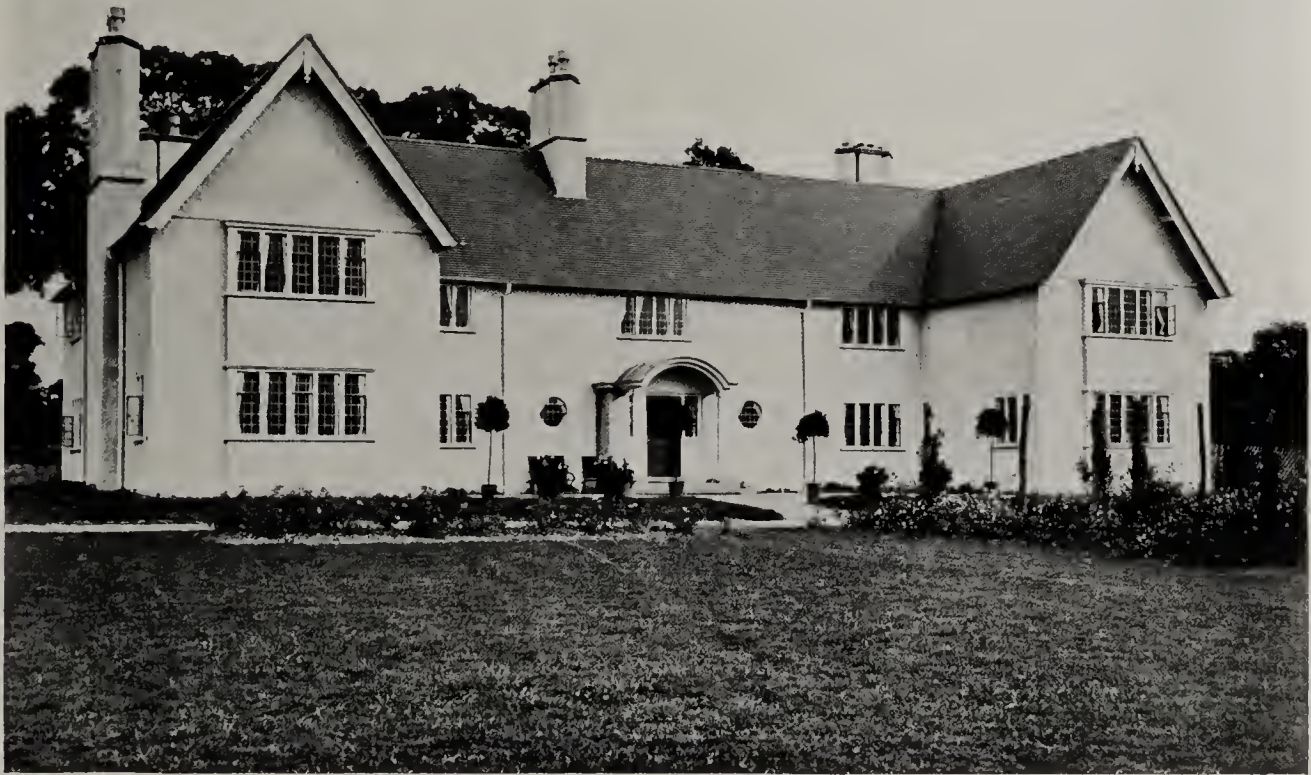
HOUSE AT HATFIELD, EXTERIOR. ARCHITECT, MR. ERNEST NEWTON, F. R. I. B. A. A. R. A.
