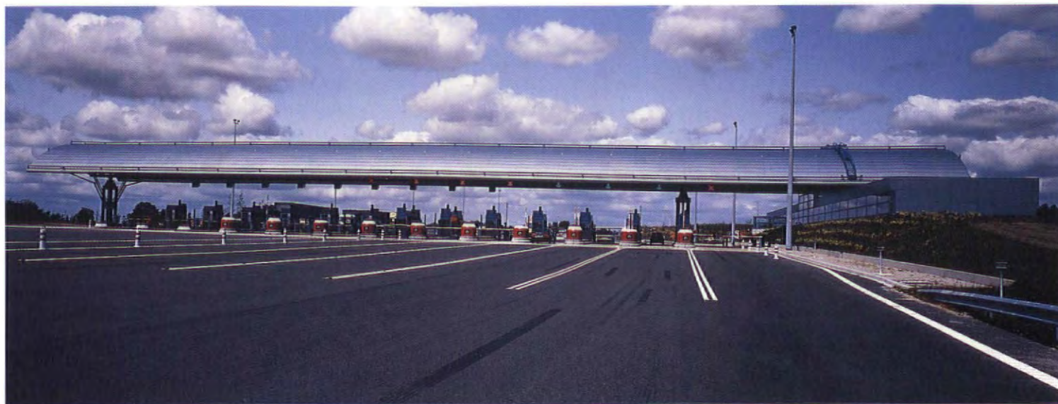
Gare en barrière du Bignon, France
